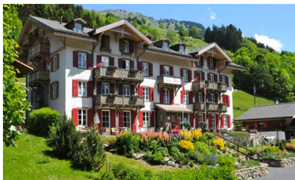
Hotel du Pillon, Les Diablerets (VD), erbaut 1875 Bild: Hotel du Pillon
